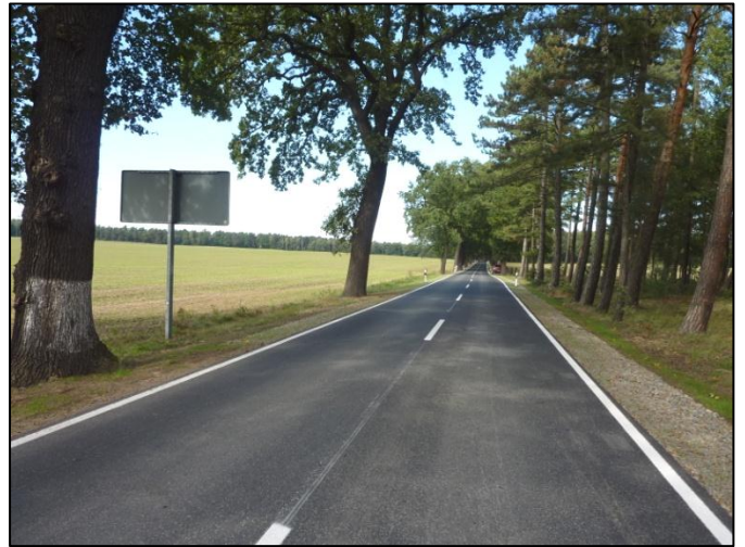
Bild 2: nach Fertigstellung der Randverbreiterung und Erneuerung der Straße
