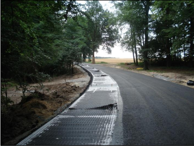
Bild 3: polygonartige Verlegung im Kurvenbereich (vor Anspritzen der Überlappungsbereiche)
