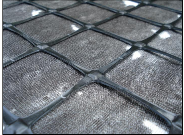
Bild 4: Detailaufnahme der verlegten Asphalteinlage Tensor AR-G (PP-Gitter mit unterseitigem Vliesstoff)
