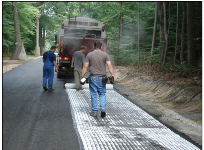
Bild 5: Verlegung Tensor AR-G in die Bitumenemulsion
